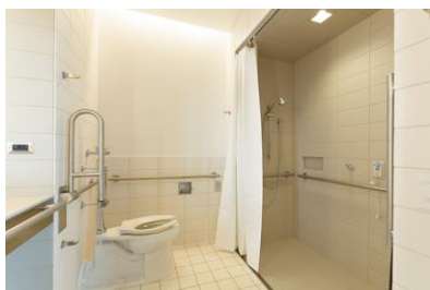
صورة رقم (3) توضح استخدام بلاطات السيراميك في حمامات المرضى نقلا عن: http://pivotek.net/news/christ-hospital-joint-spine-center-design-pre-fabrication-analysis
